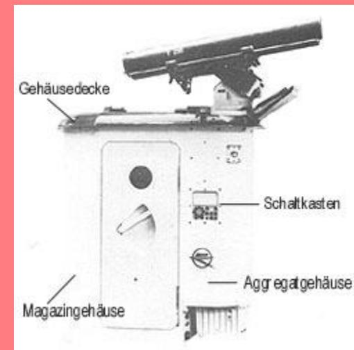
Das Magazinehäuse enthält das Trommelmagazin, den Druckspeicher und die Ausführschiene (Startrampe); nach dem Öffnen eines seitlich angebrachten gasdichten Schotts kann das Magazin nachgeladen werden.
